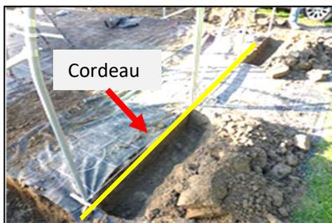
1. Le long du cordeau, de chaque côté des portes, ouvrir une tranchée de largeur 20 cm et de profondeur 30cm.
