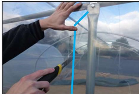
5. A l'aide d'un cutter découper la partie correspondant à la porte en conservant un débord d'environ 20cm. Commencer par les angles en coupant à 45°. Le rectangle obtenu sera une chute trop courte pour habiller la porte.
