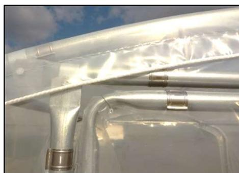
7. **Bâche avec cordelette** : retendre la cordelette si nécessaire. Dans le cas de la pose de deux pignons portes, répartir la bâche sur la longueur pour que le retour ne dépasse pas sur l'angle de porte.
