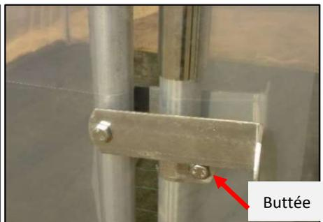
9. Percer la bâche et poser la poignée double à droite de la porte. Bien serrer les écrous à l'aide de deux clés de 13. Poser sur le montant opposé un collier U de 32mm servant de buttée.
