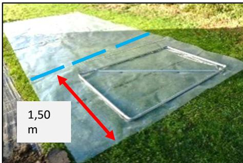
2. Dans la bâche pignon 6,50 x 2,85m découper au cutter la partie pour la porte (1,50mx2,85m) la conserver pour habiller la porte ultérieurement à l'aide de 14 clips INOX en 32/30mm. Soit 4 par côté long et 3 par côté court.
