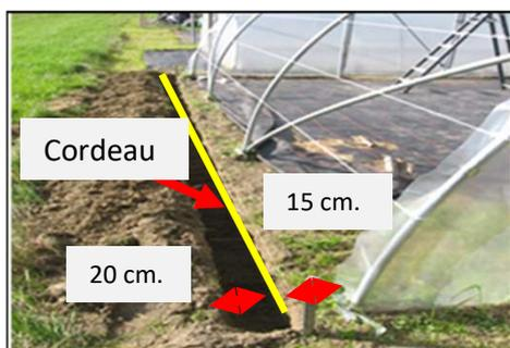
1. à l'aide d'un cordeau posé à 15cm de la structure ouvrir une tranchée de 20cm de largeur et 30cm de profondeur, 35cm en cas de sol léger.
