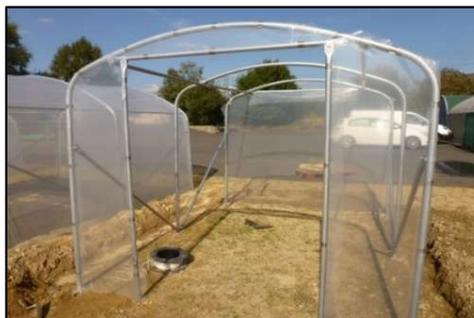
7. Poser 4 clips 32/30 par montant et 3 clips sur la traverse horizontale. Couper ensuite les excédents de bâche. **Habiller la porte avec le rectangle de 1,50m x 2,85m et 14 clips en 32mm par porte.**
